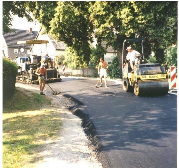
Erneuerung der Radlubinstraße
