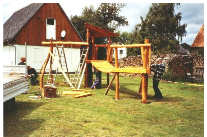
Ein neuer Spielplatz wird errichtet
