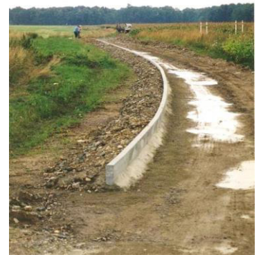
Bau des Radwegs zwischen Rosenthal und Laske
