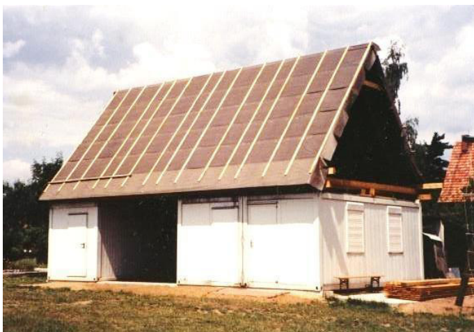
Beim Bau des Vereinshauses
